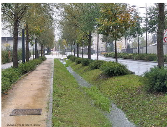
Chodník z přírodních materiálů v kombinaci s příkopem a zelení
