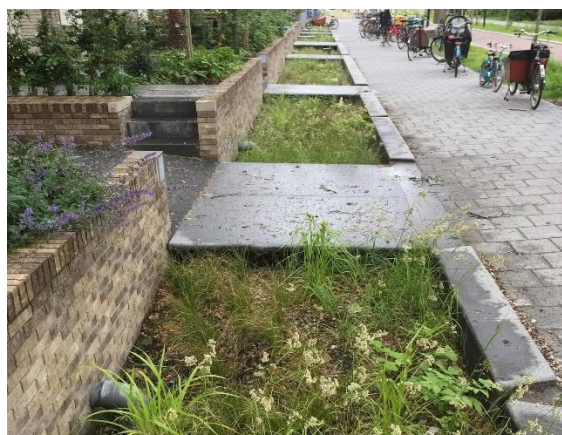
Spádování chodníku do zasakovacího průlehu
