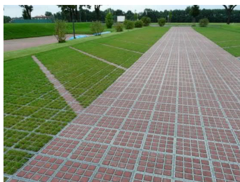
Příjezdová cesta na parkovišti z propustných materiálů
